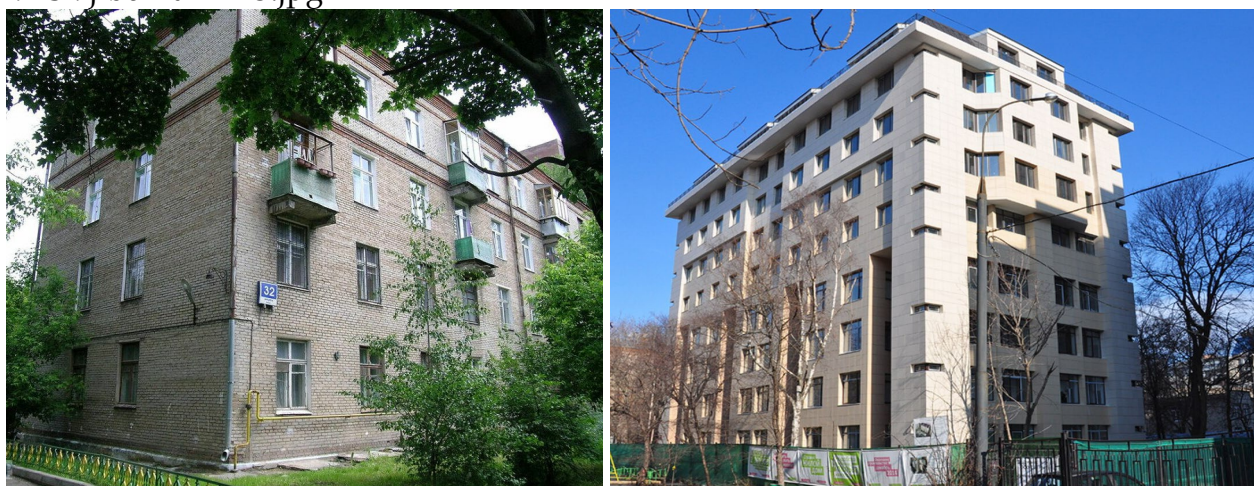
Рисунок 6.г.Москва ул. Мишина 32 , до и после реконструкции.
