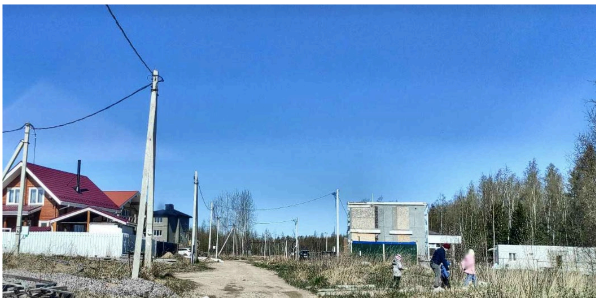
Рис. 2. Отсутствие полноценной среды благоустройство и инфраструктуры на
