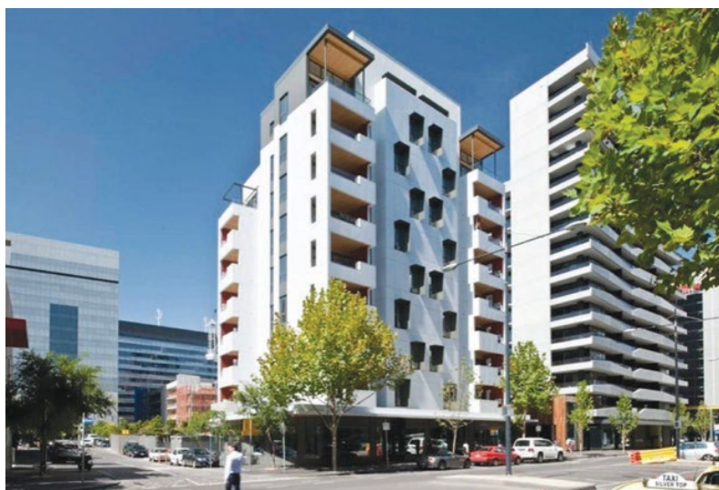
Рисунок 3 – Десятиэтажное здание Forté. Мельбурн, Австралия [1,3]
