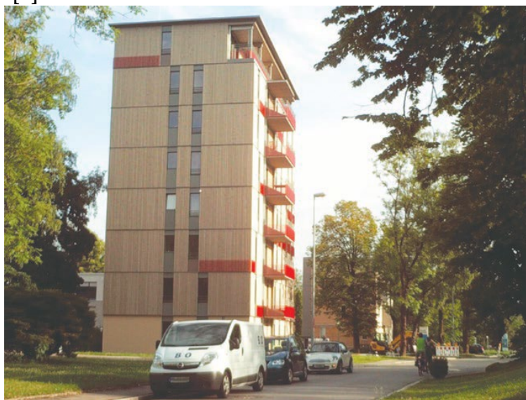
Рисунок 2 – Восьмиэтажный деревянный жилой дом. Бад-Айблинг, Германия [3]
